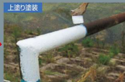
乾燥後、一般塗料で上塗り塗装。
