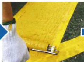
専用のローラーを用いて塗布面にパターン(凸凹)付けし、仕上げます。
