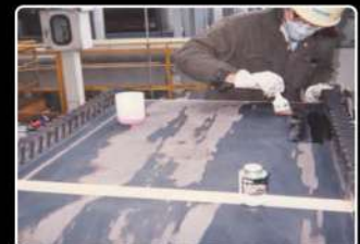
給炭機の 石炭運送用ベルコンの補修
