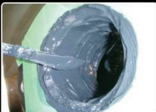
復水器フランジ内部の ゴムライニング補修
