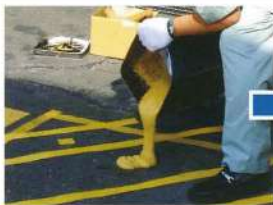
混合したすべり止めコートを塗布面に直接垂らします。
